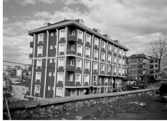
K, 14: Yeni yapılan apartman.
