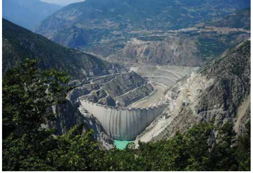
Karadeniz'de HES inşaatı. Kaynak: ekopangea.com
